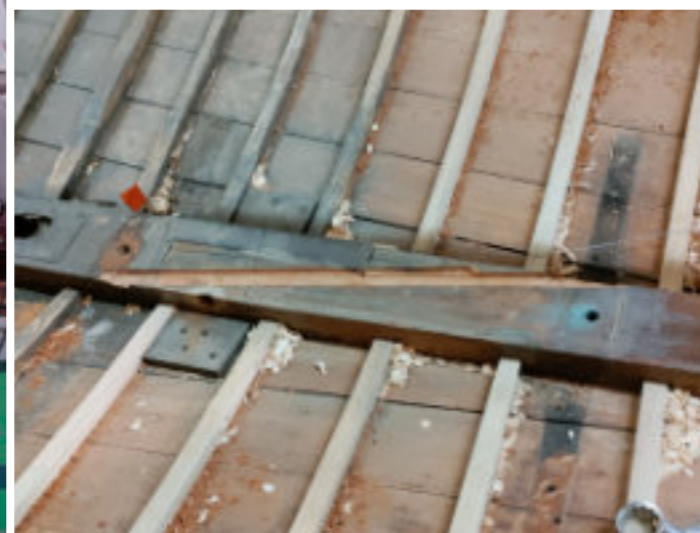
Perärangan viistoliitos työn alla, vasemmalla näkyy vanha tääkipulteilla koottu korjaus.
